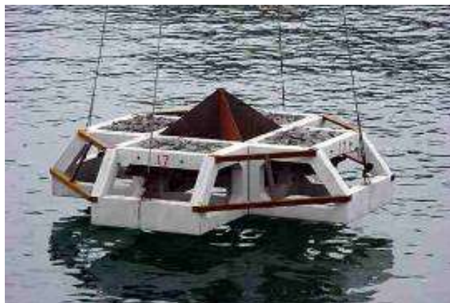
図 1-59 設置された攪拌ブロック礁（岸和田市地先）
