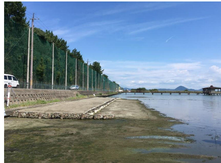
覆土工完了（木浜内湖）
