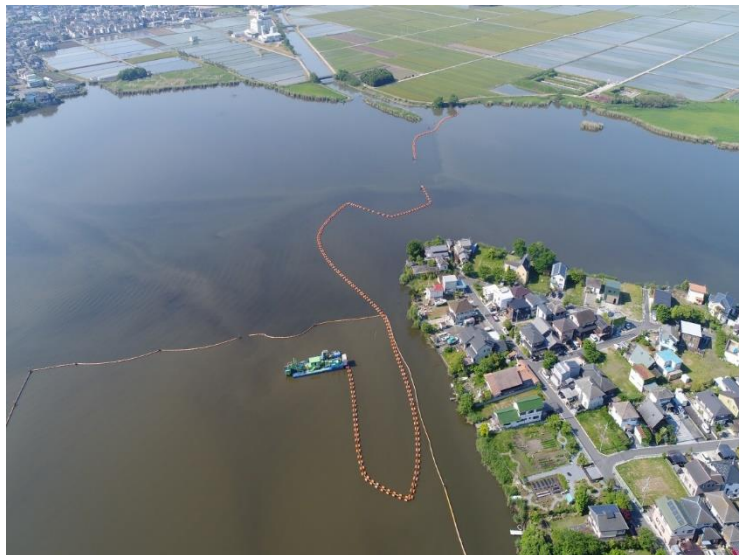
浄化浚渫の実施状況（西の湖）
