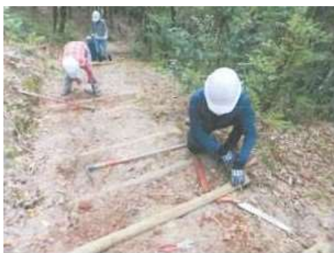
歩道整備（伊崎国有林）
