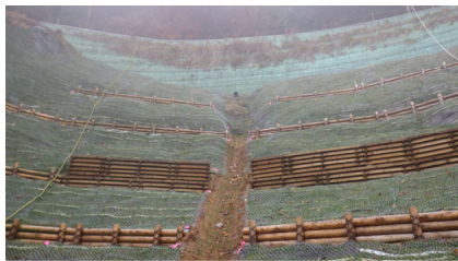
丸太筋工・木製柵筋工（奈良県内）
