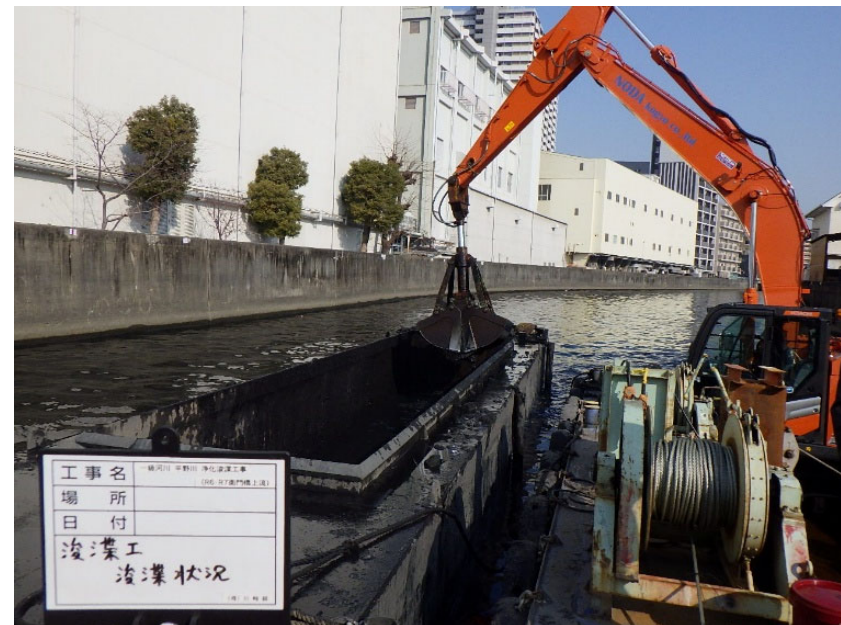
河川浄化浚渫工事（平野川）
