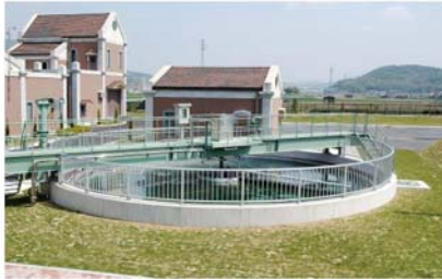
整備した下水処理場 (南あわじ市広田じょうかセンター)
