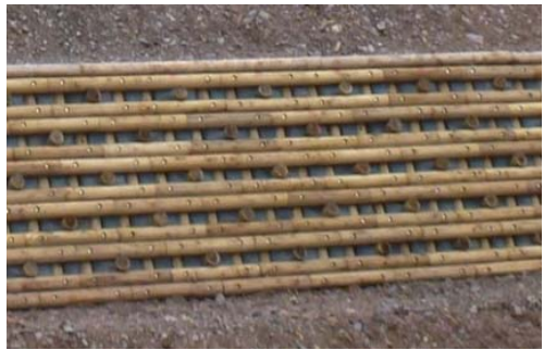
木製ブロック土留工 写真提供：近畿中国森林管理局
