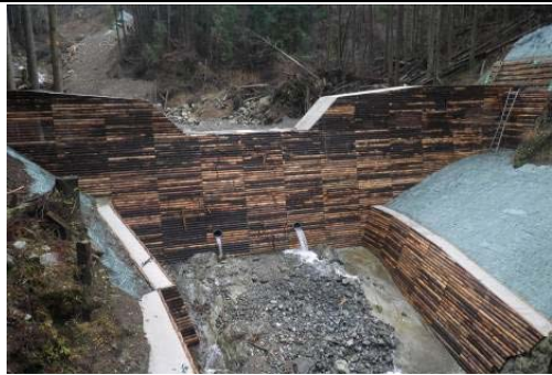
治山ダムに間伐材利用の残存型枠を設置 写真提供：奈良県
