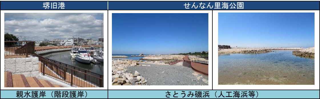
■親水護岸（階段護岸）、人工海岸等（緩傾斜護岸等）の整備状況
