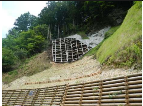
間伐材を用いた木製土留工 写真提供：奈良県
