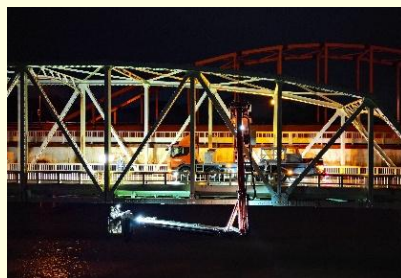
国道42号 熊野大橋（和歌山県）
