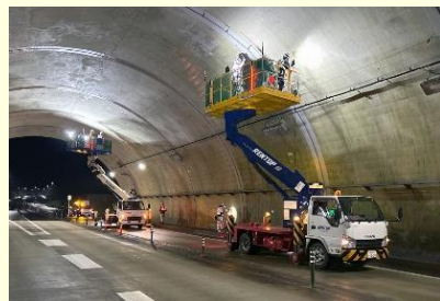
E42近畿自動車道松原那智勝浦線 周参見第二トンネル（和歌山県）
