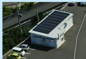
再生可能エネルギーの活用事例（太陽光パネル設置：道の駅 すさみ）
