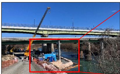
国道24号（京都府京都市）
