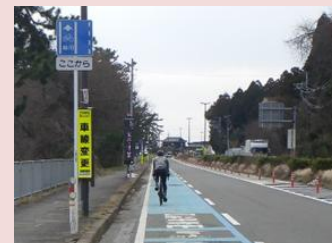
自転車通行空間の整備事例（自転車専用通行帯：国道161号 高島市）
