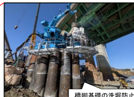
橋脚基礎の洗堀防止対策工事中
