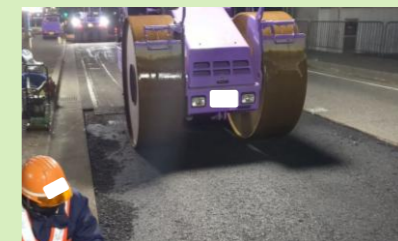
低炭素な材料の導入事例(低炭素(中温化)アスファルト導入:滋賀国道事務所管内)
