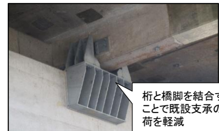
国道26号 堺高架橋(大阪府堺市)
