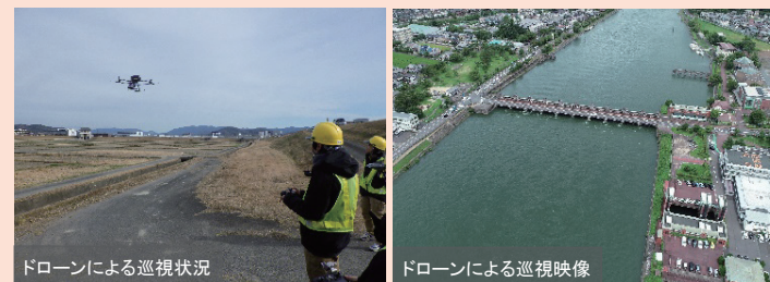
ドローンによる巡視状況
