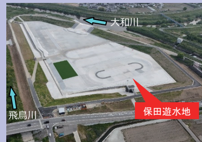
遊水地整備（大和川）
