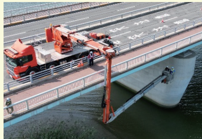
国道26号 紀の国大橋（和歌山県）
