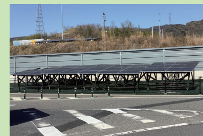
パーキングエリア内の敷地を活用した整備事例（京奈和自動車道 かつらぎ西PA）
