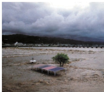
平成2年洪水時の新六ヶ井堰周辺の様子
