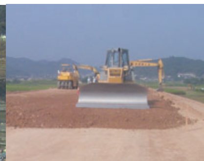
由良川：輪中堤(わじゅうてい)整備 堤防で囲うことでその地域を洪水の氾濫から守ります
