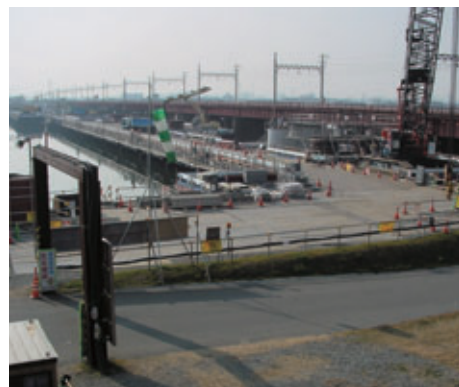
JR橋梁替工事状況（右岸側）
