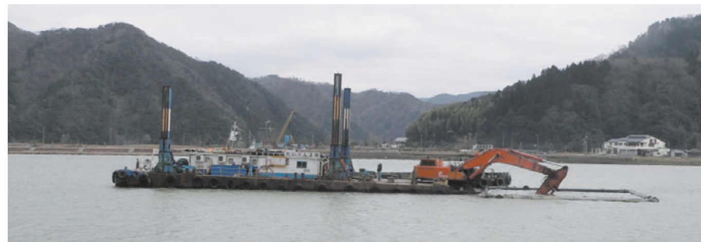
円山川：河床掘削(かしょうくさく)状況 河床掘削により降雨時に低水位を確保し洪水防止を図ります
