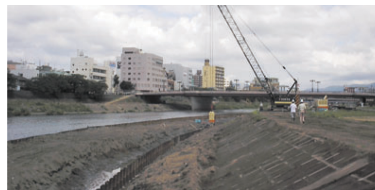
足羽川：護岸工事状況 護岸を補強し洪水防止を図ります
