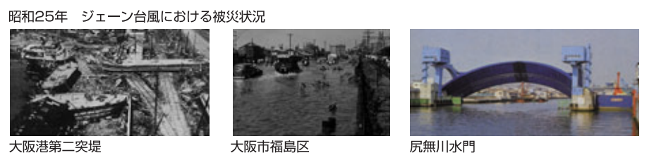
昭和25年 ジェーン台風における被災状況
