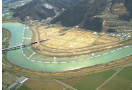
河床掘削状況 (日野川)
