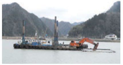
河床掘削状況 (円山川)
