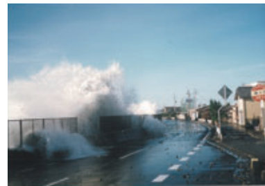
越波発生状況(串本町西向地区)
