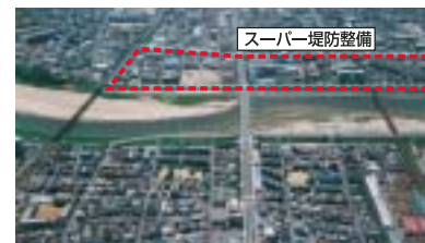
大和川スーパー堤防整備
