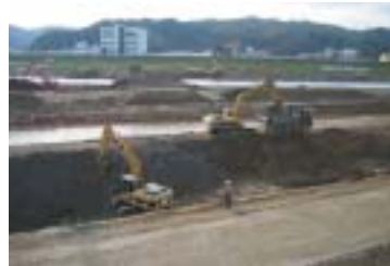
■円山川の河川激甚災害対策河床掘削状況
