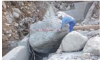
崩壊した河川の被災状況調査を実施(平成29年九州北部豪雨)
