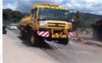
路面に堆積した土砂を撤去(平成29年九州北部豪雨)
