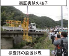
検査路の設置状況
