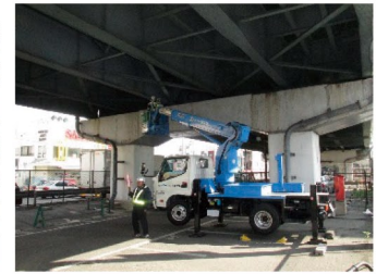
大阪府国道43号 四貫島高速高架橋
