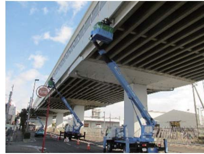
橋梁点検の事例
