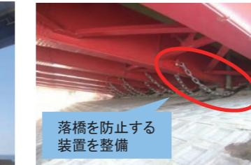
橋脚補強と落橋を防止する装置を整備
