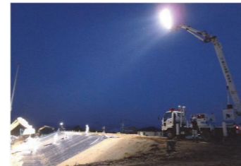
緊急工事を照明車で支援 (平成28年4月熊本地震)
