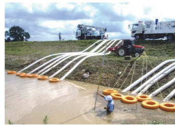
整備局ポンプ車による排水作業
