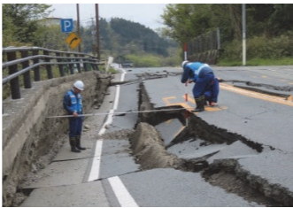
道路被災箇所への調査
