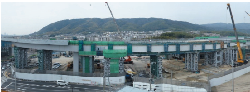
工事が進む京都第二外環状道路（京都府長岡京市）
