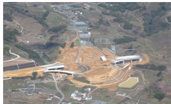
工事が進む紀北東道路（和歌山県かつらぎ町）
