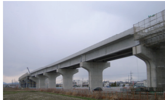
工事が進む大和御所道路（奈良県 橿原市）
