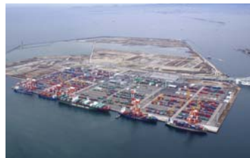
夢洲コンテナターミナル
