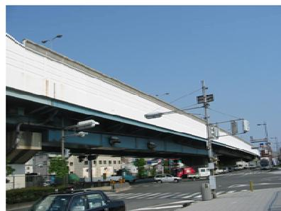
一般国道43号(大阪市西淀川区) 遮音壁への光触媒塗布
