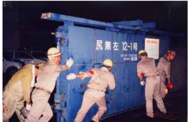
電動化・軽量化等の改良が待たれる 防潮鉄扉 (写真は訓練時の状況)
