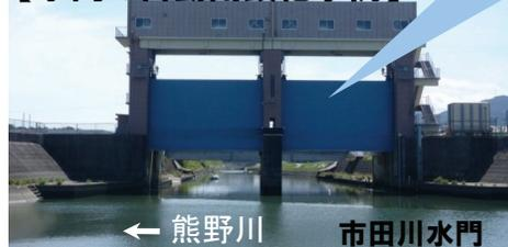
自動でゲートを閉鎖させる
