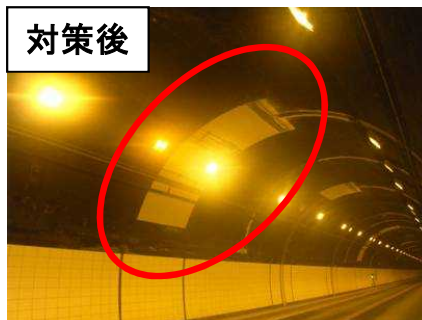
断面修復・剥落防止
