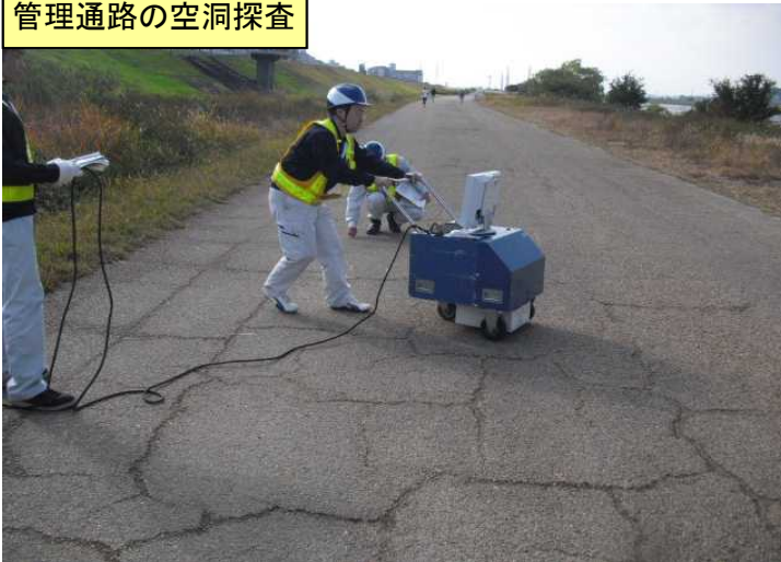
管理通路の空洞探査
