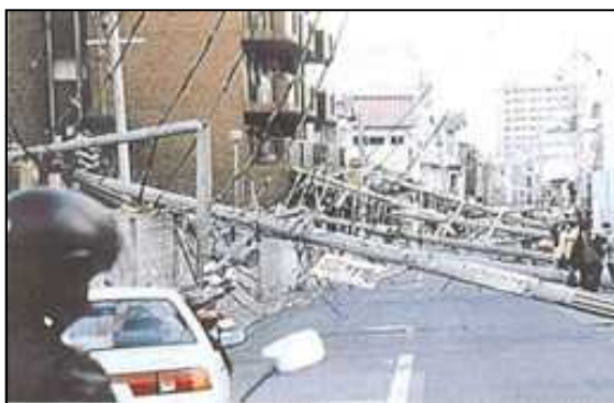
電柱の倒壊による道路閉塞
