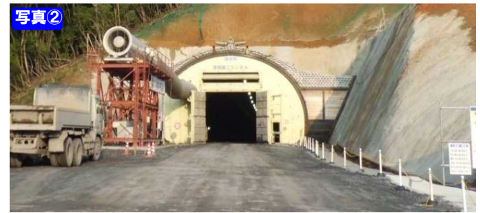
＜須知第二トンネル(宮津側坑口部)＞
