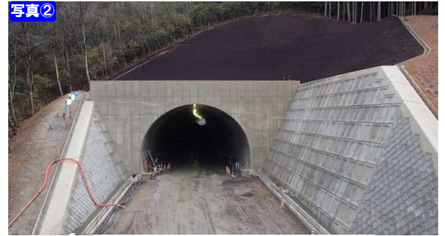
＜須知第二トンネル(宮津側坑口部)＞
