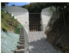
透過型堰堤の整備
