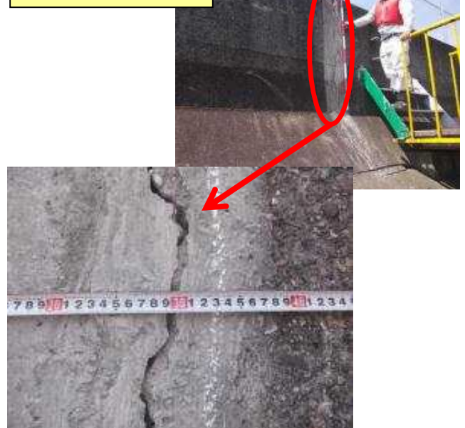
堤防損傷調査(高潮堤)
