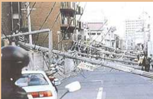
電柱の倒壊による道路閉塞
