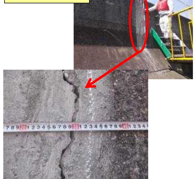
堤防損傷調査(高潮堤)
