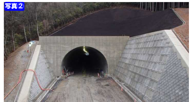
<須知第二トンネル(宮津側坑口部)>
