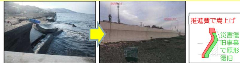
被災した護岸を災害復旧事業による原形復旧にあわせて、推進費により高上げを実施。
