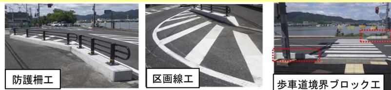
園児の移動経路（交差点）において発生した死傷事故を受けて、緊急点検の結果、危険箇所に防護柵等を設置。
