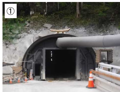
仮称1号トンネル整備状況
