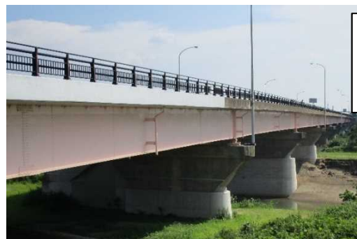
木津川大橋(全景)
