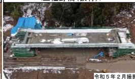
③ 工事状況写真 〈上佐野橋(仮称)〉
