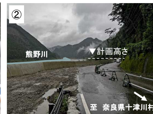
現道拡幅部整備状況
