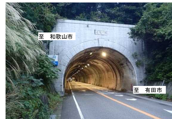
鯨川トンネル(全景)
