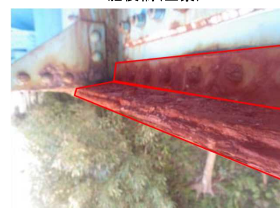
対策イメージ(あて板補修+塗装)
