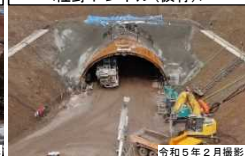
② 工事状況写真 〈佐野トンネル(仮称)〉
