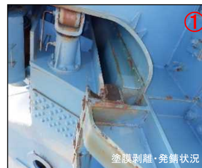
<現状>放流ゲートの老朽化状況
