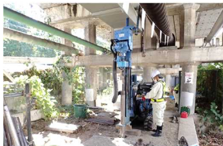
地質調査の状況
