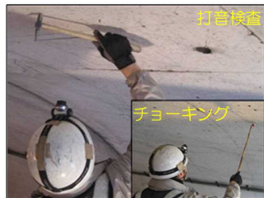
【近接目視・打音検査状況】
