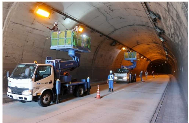
【トンネル点検車による点検状況】
