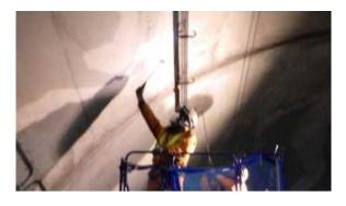
【打音検査】 トンネルのコンクリート面を点検ハンマーで叩いてうきやはく落の危険が 無いか確認します。危ないものがあれば叩き落とします。
