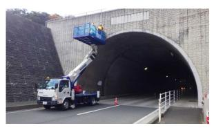
【近接目視(高所)】 トンネルのコンクリート面に近づい てひび割れや漏水量を計測します。近 接目視の結果は変状展開図と写真に記 録を残します。
