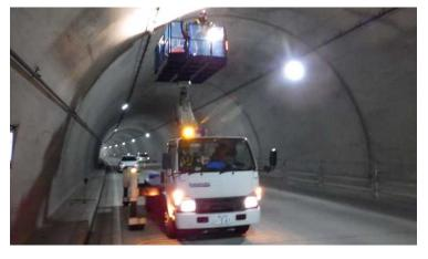
点検車という車両を使って点検をします。見た目は高所作業車ですね。 でも特殊な仕掛けがトンネル点検車 にはあります。
