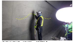
【近接目視(側壁・路面)】 トンネルの横のコンクリートや路面 にひび割れや段差などが無いか確認し ます。
