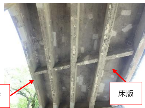
RCT 桁橋 国道 176 号 越之子橋
