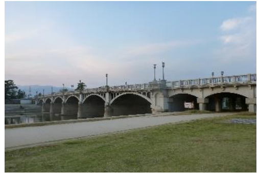
アーチ橋 国道2号 武庫大橋
