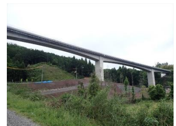
国道483号 山本高架橋
