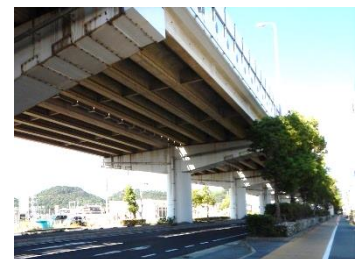
国道2号 曾根高架橋 プレテンション方式
