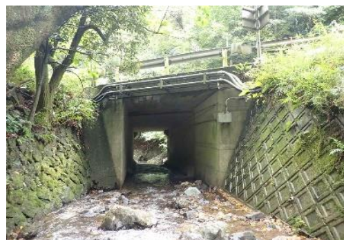
RC 床版橋 国道 9 号 北ノ領橋
