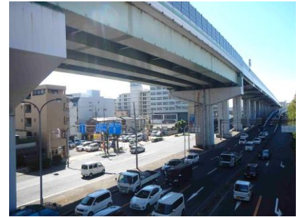
堺高架橋 箱桁の部分
