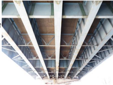
堺高架橋 鈹桁の部分
