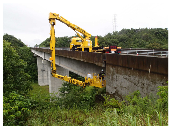
【橋梁点検車による点検状況】
