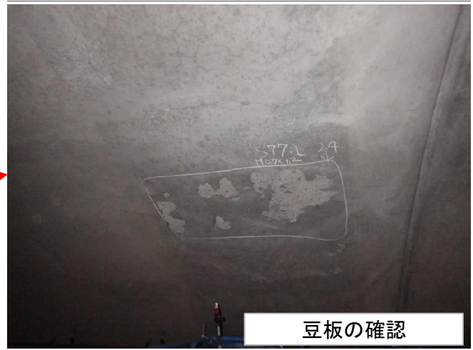
写真-4 スクリーニング確認箇所(近景)
