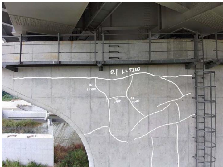
写真-3 梁部(ひびわれ W=0.1\text{mm:b} )
