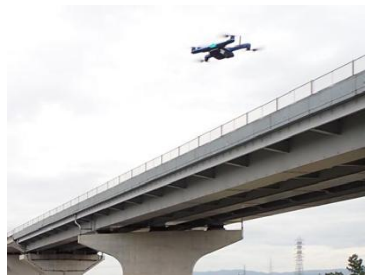
写真-2 ドローン点検状況
