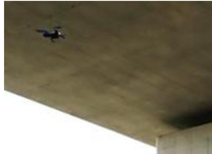
写真-2 ドローン点検状況
