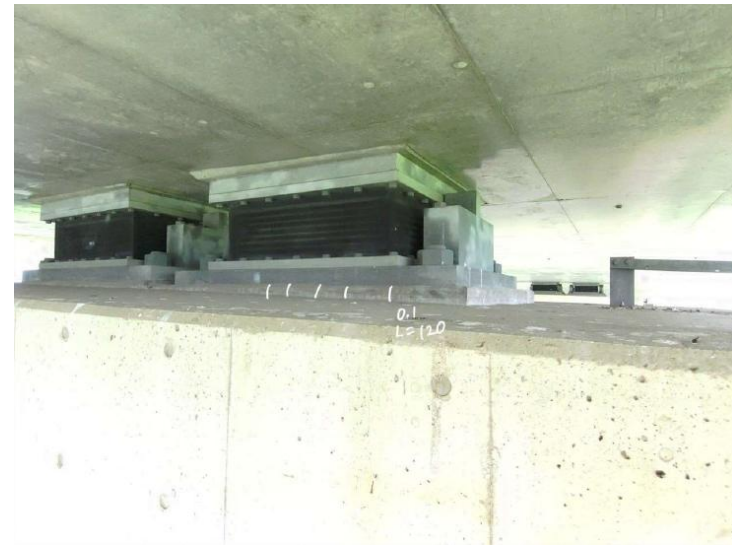
写真-4 沓座モルタル(ひびわれ W=0.1\text{mm:b} )
