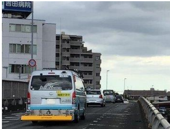
写真-1 点検状況(斜め後方)
