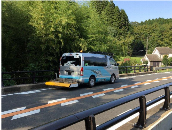
写真-1 点検状況(斜め後方)
