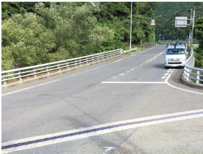
写真-3 点検状況(前方)
