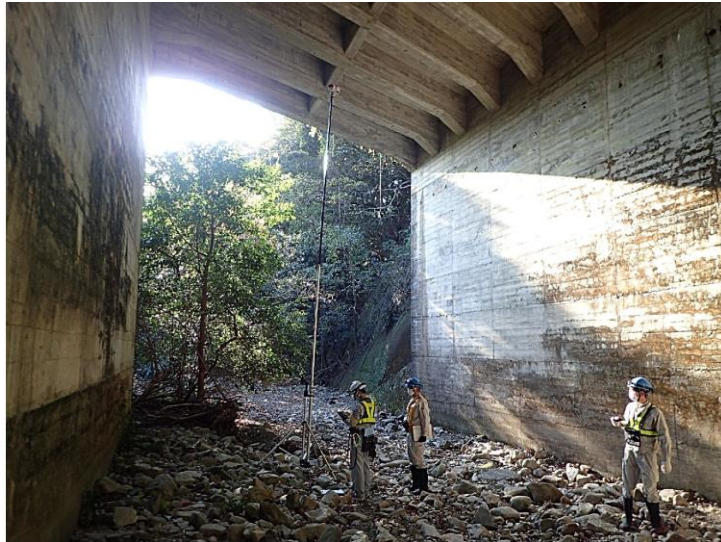
写真-1 点検状況
