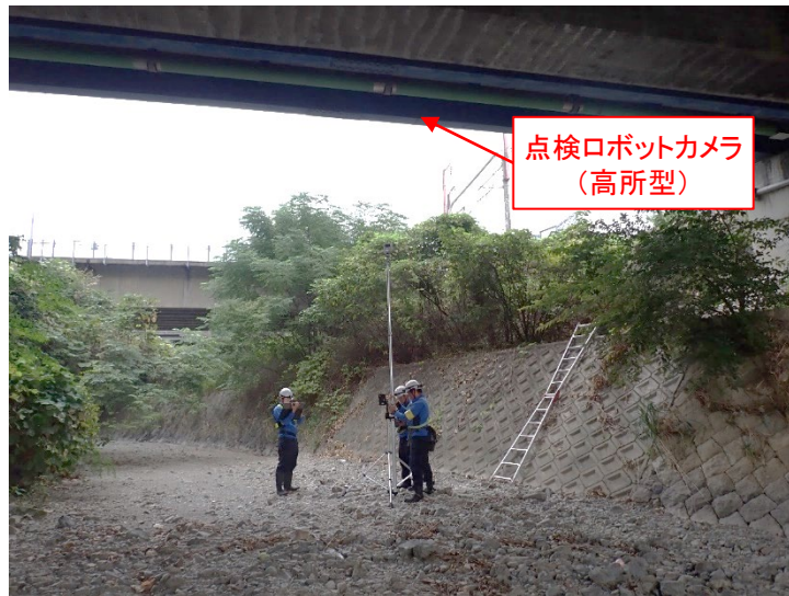
写真-1 点検状況
