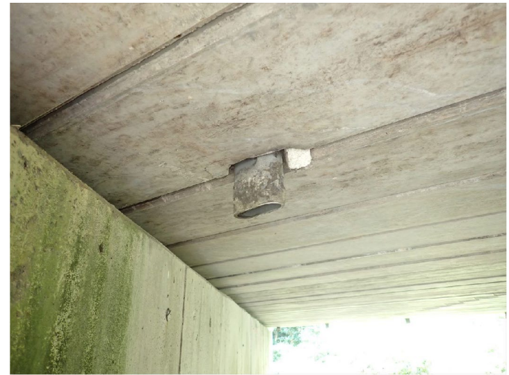
写真-4 排水管(健全)
