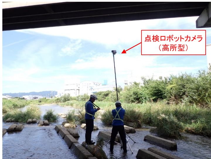
写真-1 点検状況
