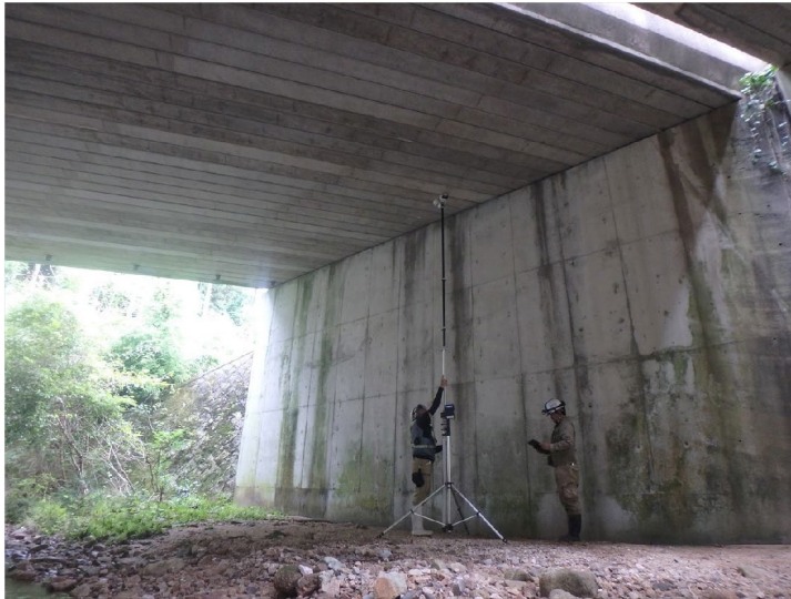
写真-1 点検状況
