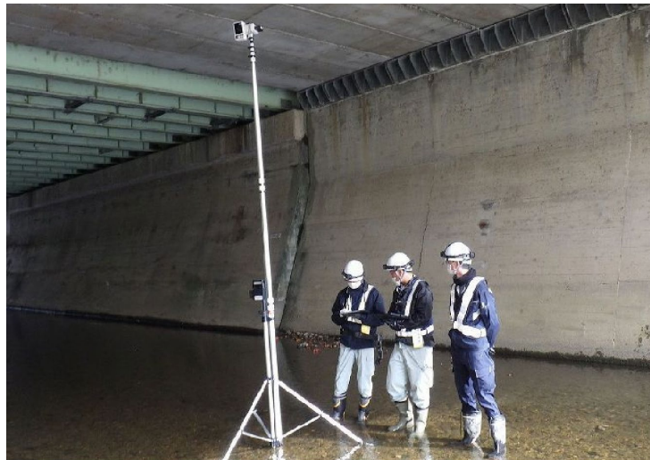
写真-1 点検状況
