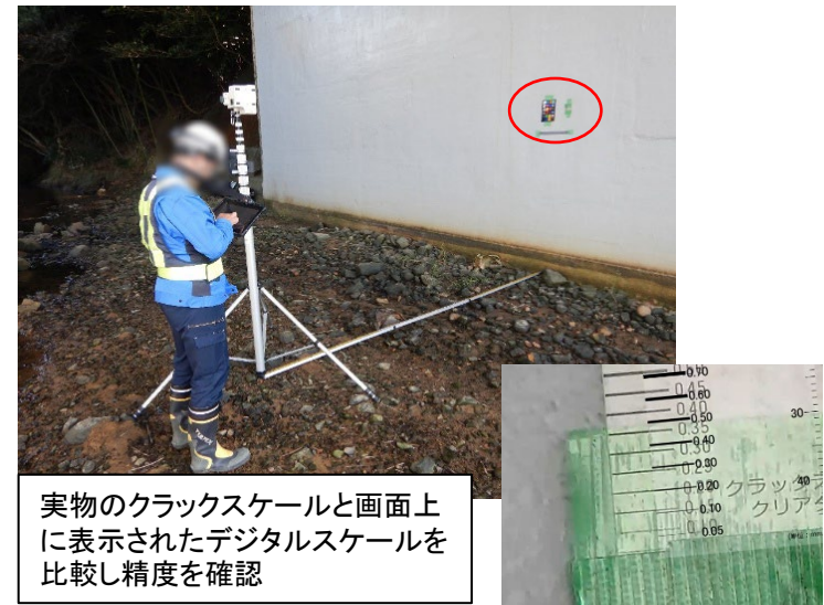
写真-2 キャリブレーション状況
