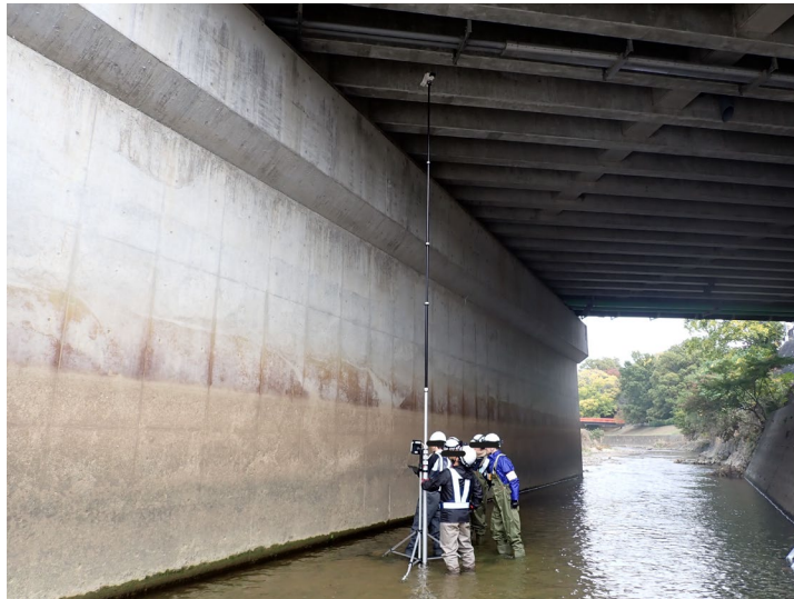
写真-1 点検状況
