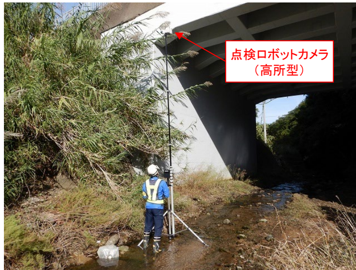
写真-1 点検状況
