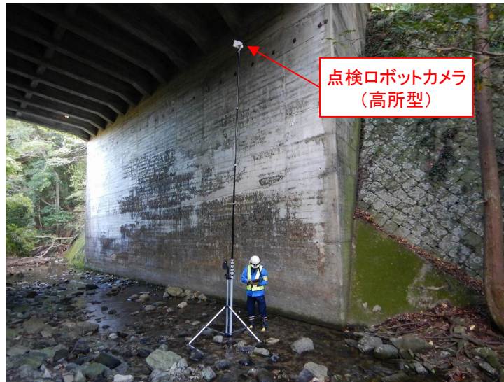
写真-1 点検状況
