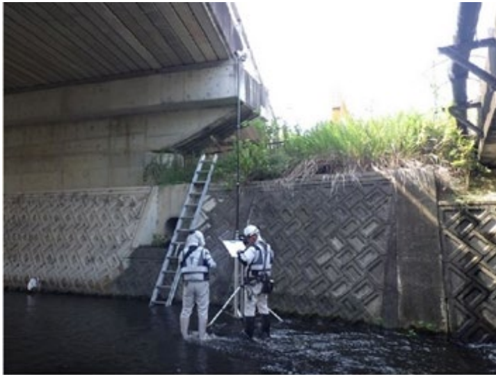
写真-1 ロボットカメラによる撮影状況
