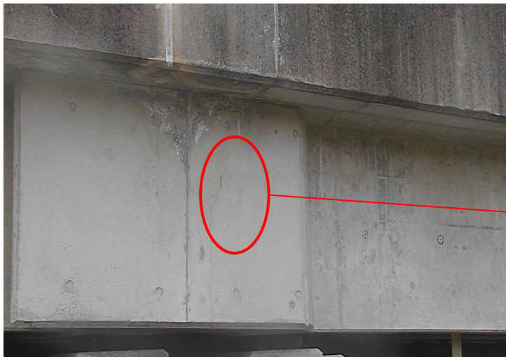
写真-3 PC定着部(ひびわれ W=0.2mm)
