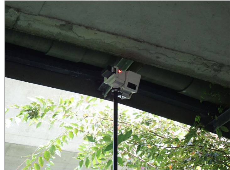
写真-2 点検状況[カメラアングル確認・調整]
