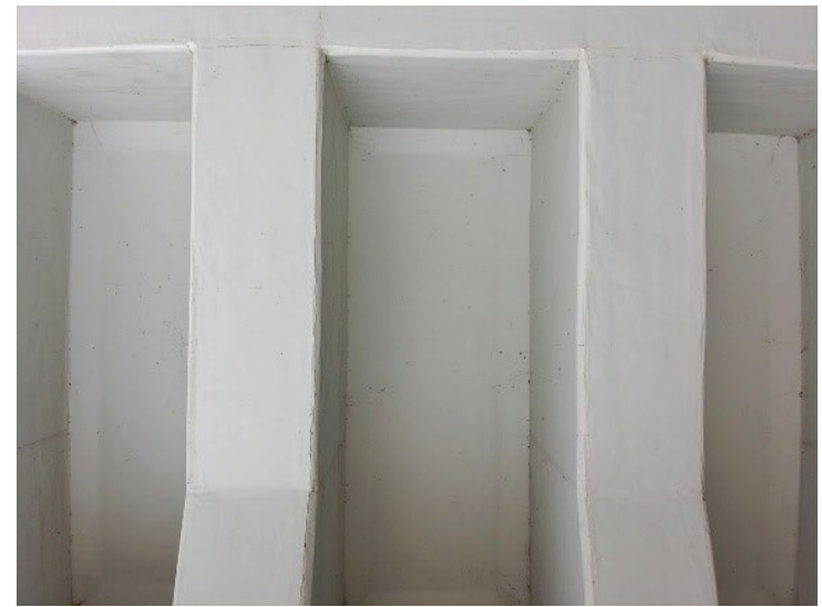
写真-4 床版(健全)
