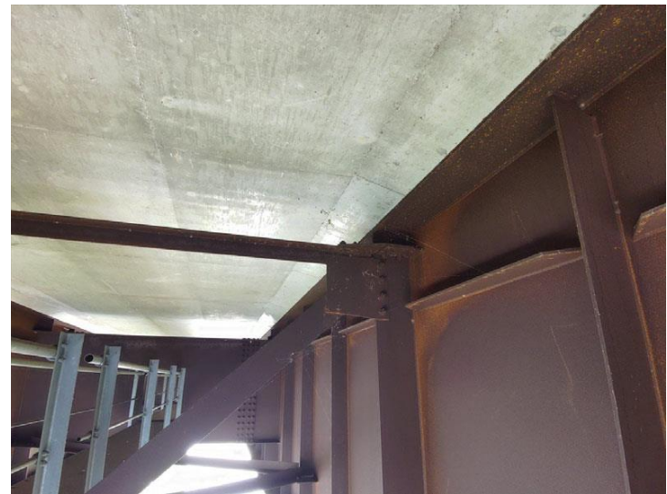
写真-2 対傾構(健全)
