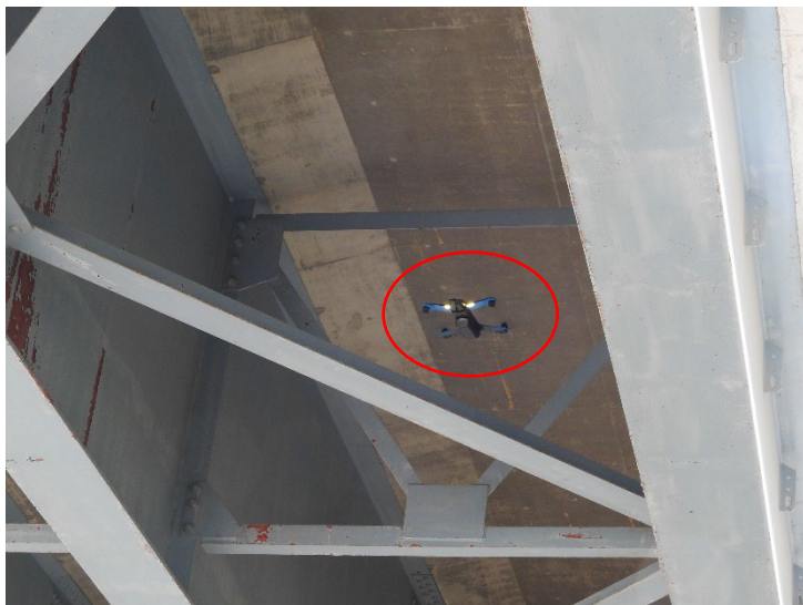
写真-1 点検状況
