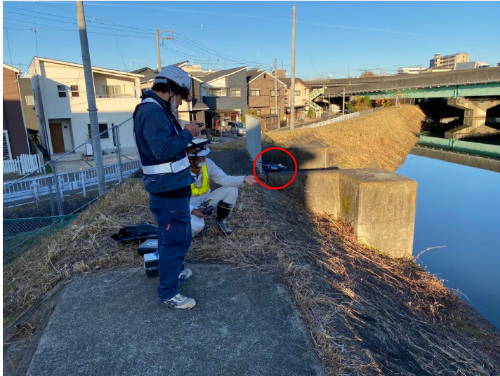
写真-1 ドローンによる撮影状況
