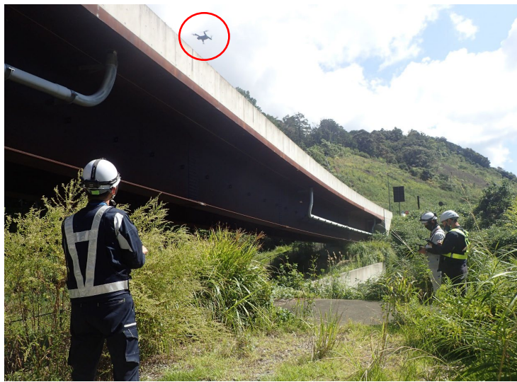
写真-1 点検状況
