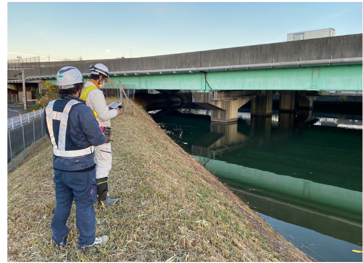
写真-2 ドローン操作状況
