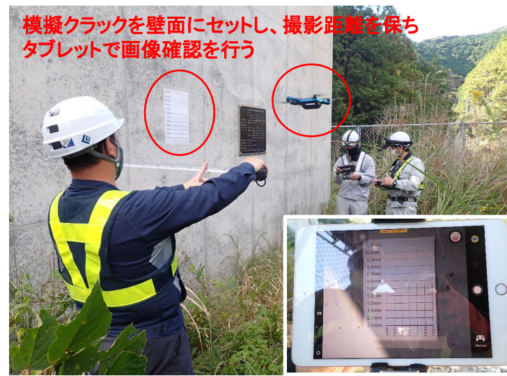
写真-2 キャリブレーション状況
