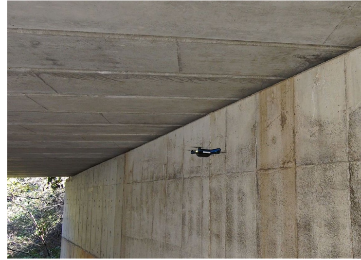
写真-2 ドローン点検状況
