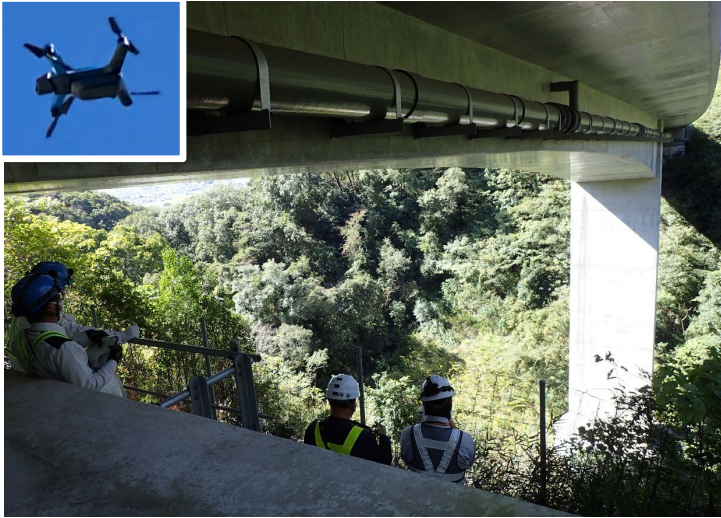
写真-1 点検状況
