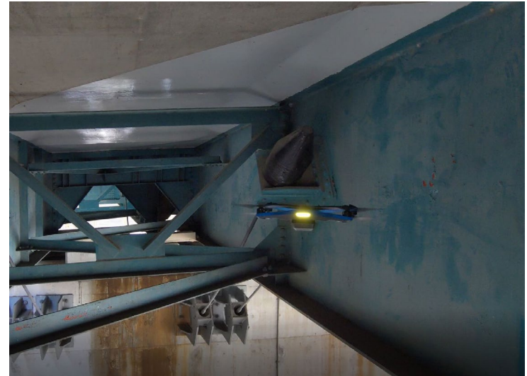
写真-2 ドローン点検状況
