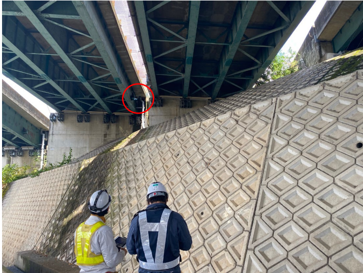
写真-1 ドローンによる撮影状況
