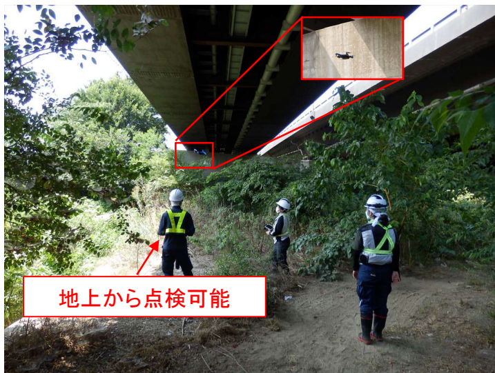
写真-1 点検状況
