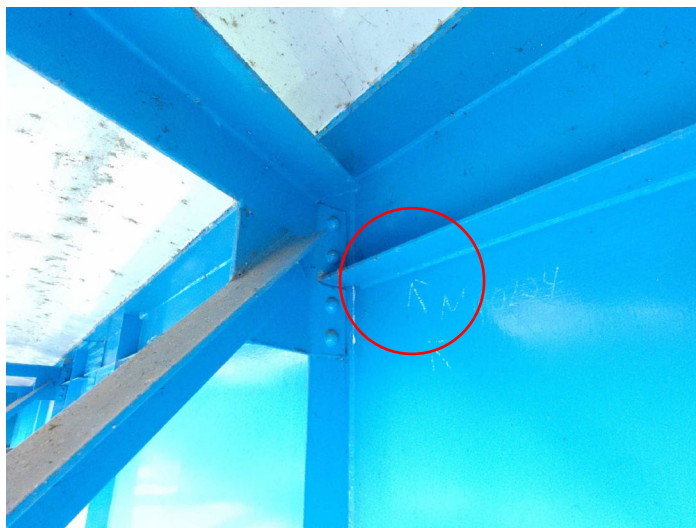
写真-3 主桁(亀裂なし:a)
