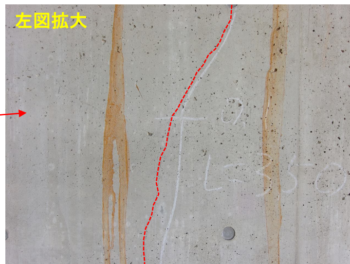
写真-4 ひびわれ[W=0.1mm,L=3500mm]
