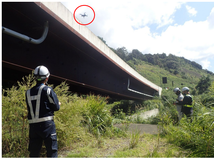
写真-1 点検状況
