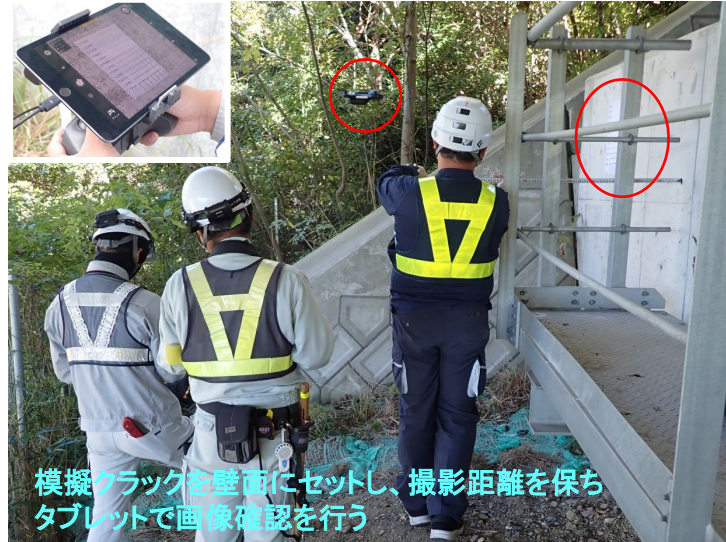
写真-2 キャリブレーション状況
