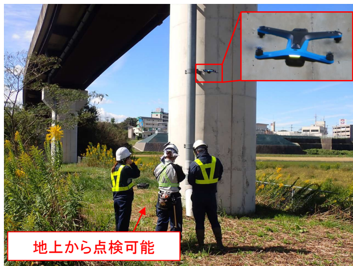
写真-1 点検状況
