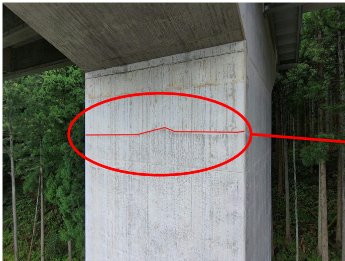
写真-3 橋脚(ひびわれ W=0.1mm: 損傷程度b)
