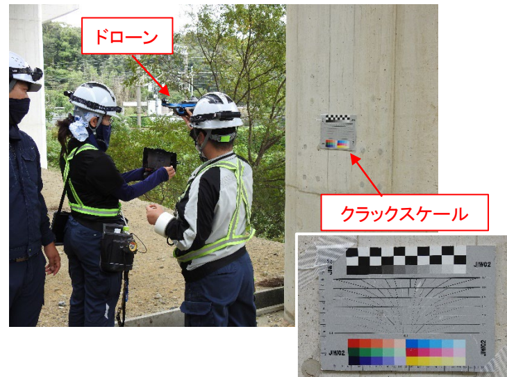
写真-2 キャリブレーション状況
