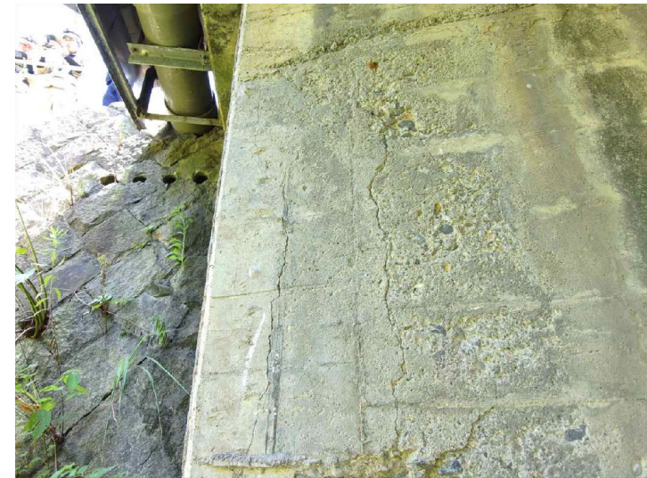
写真-4 縦壁(ひびわれ:d)
