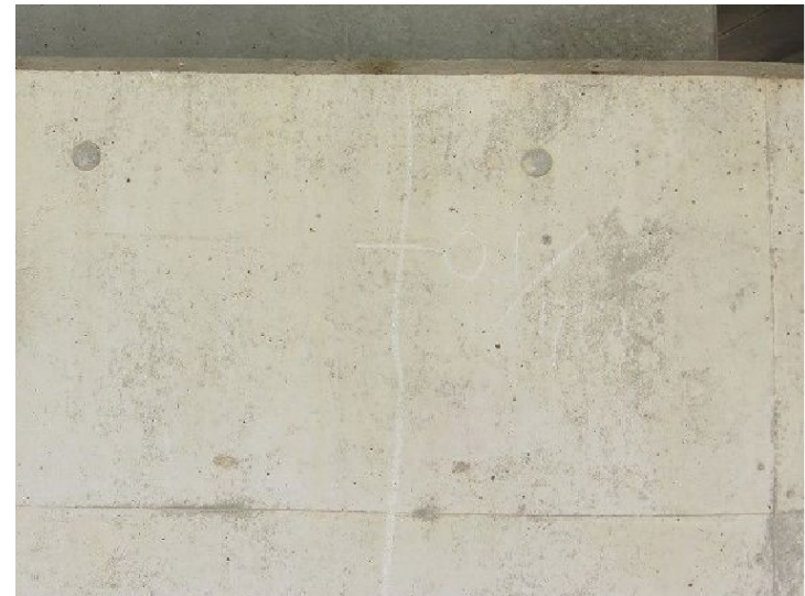
写真-4 梁部(ひびわれ W=0.1\text{mm:b} )
