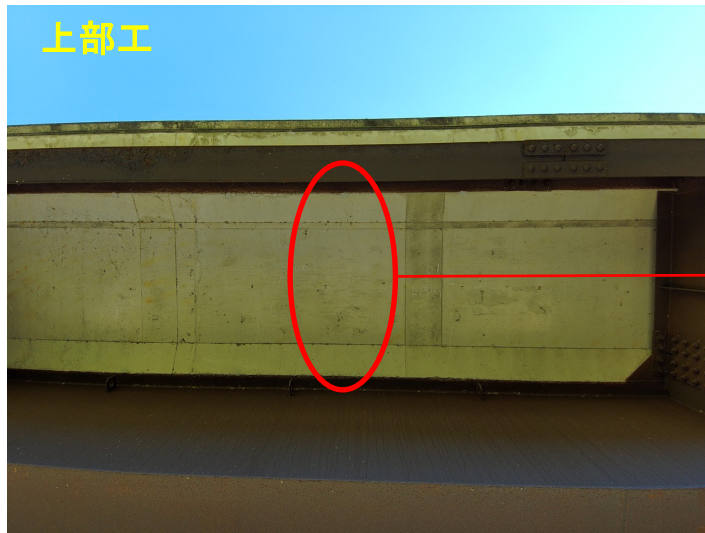
写真-3 損傷確認(床版ひびわれ)
