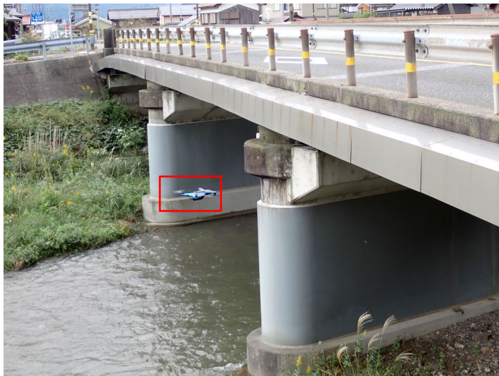
写真-1 点検状況
