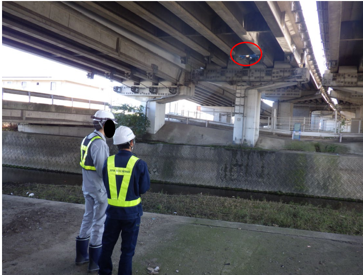
写真-1 ドローンによる点検状況
