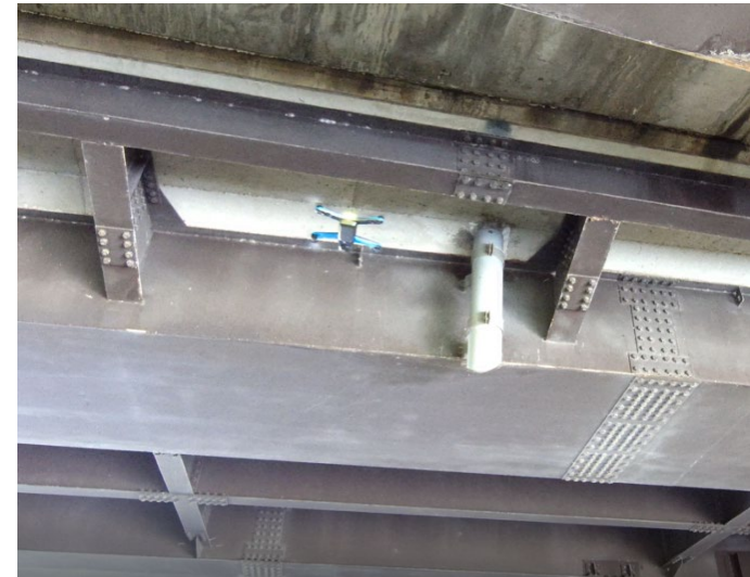
写真-2 ドローン飛行状況
