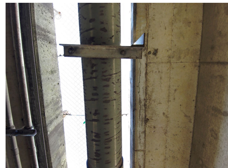
写真-4 地覆(ひびわれ w=0.8\text{mm} )
