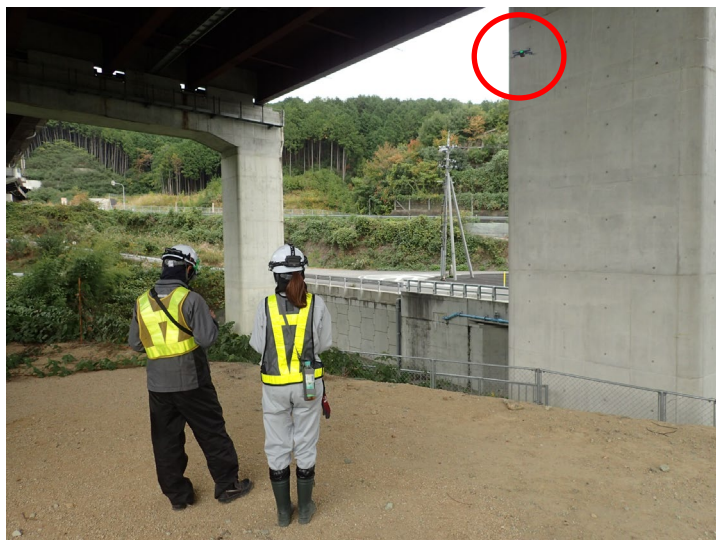
写真-1 点検状況
