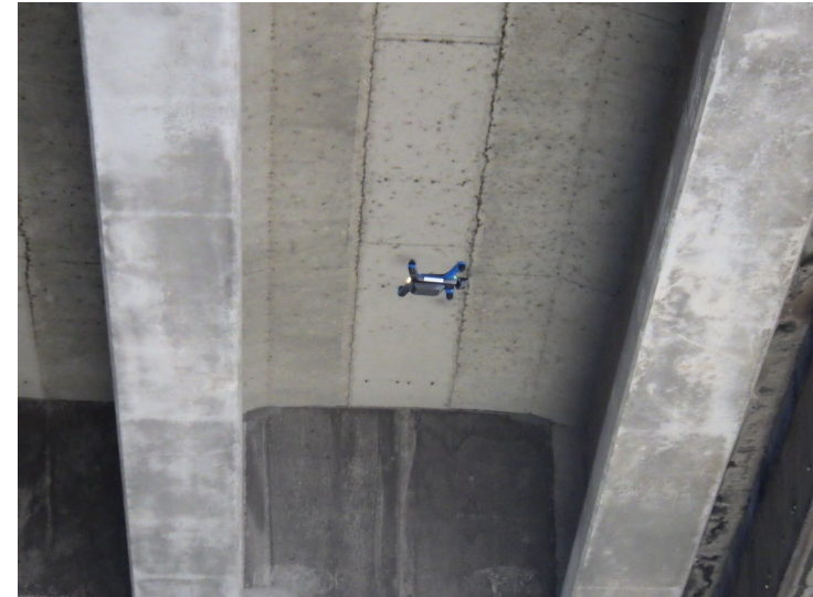
写真-2 ドローン点検状況
