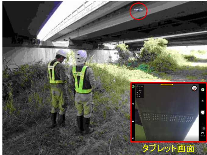
写真-1 ドローン操作状況
