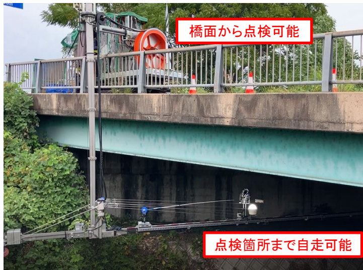
写真-1 点検状況
