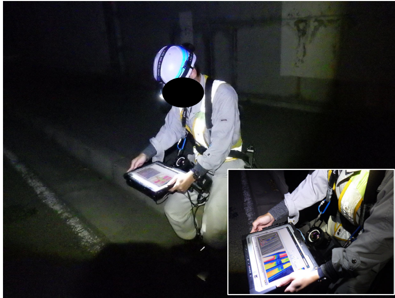
写真-1 Jシステムによる調査状況
