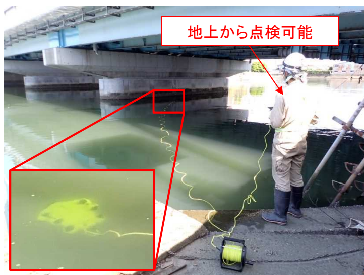
写真-1 点検状況
