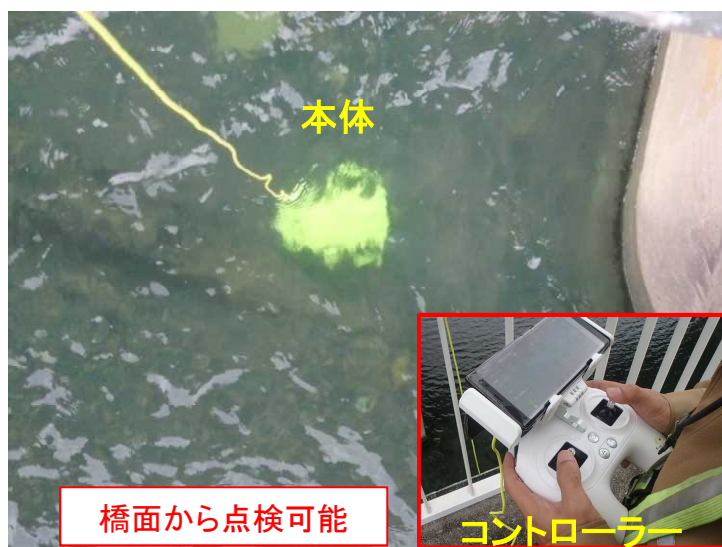
写真-1 点検状況
