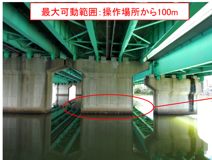
写真-3 点検対象橋脚の状況(水中部対象)
