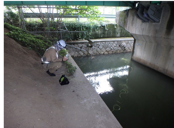
写真-2 点検状況
